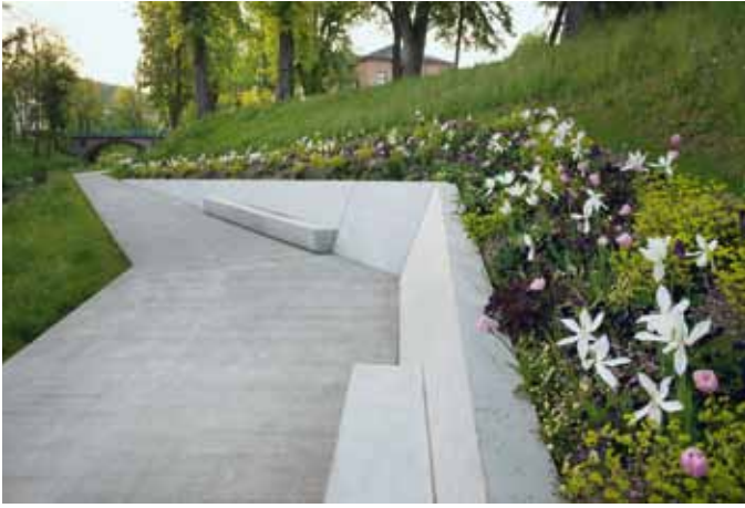
Entlang des Josefsbachs in Schwäbisch Gmünd legte das Berliner Büro A24 Landschaft ein „Promenadenband“ mit Betonelementen in die Uferböschung.
