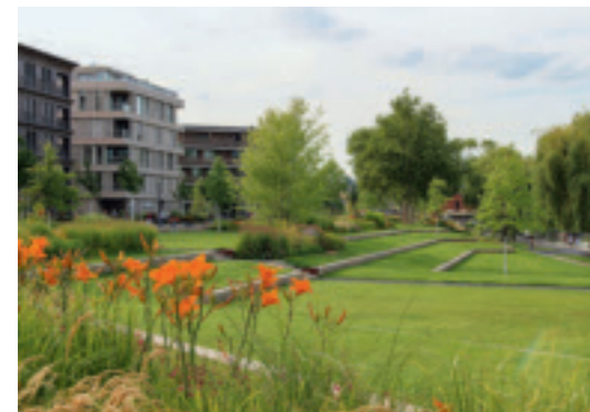
Landschaftsterrassen am Neckar. Hier befand sich bis zu ihrer Verlegung im Vorfeld der Buga eine Bundesstraße. Fotos: Sinai
