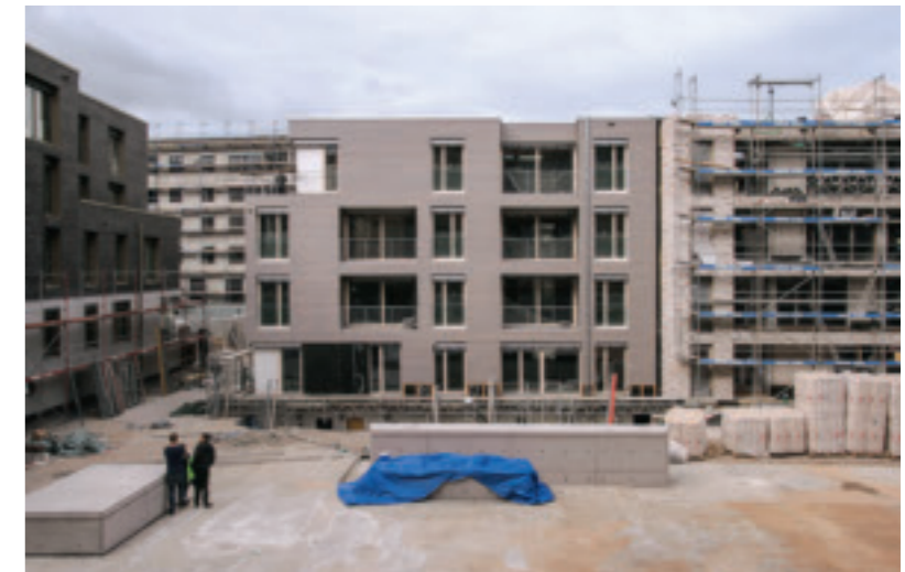
Auf dem Stuttgarter Olga-Areal baut die Baugemeinschaft Max Acht ein Massivholzgebäude (Arch.: Architekturagentur, Stuttgart). Die Konzeptverfahren auf dem ehemaligen Klinikgelände folgen weitgehend dem Modell eines Architekturwettbewerbs. Foto: Architekten
