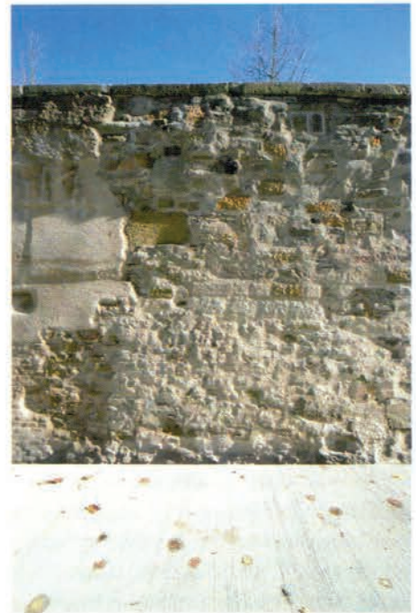
Frisch sanierte Stadtmauer.
