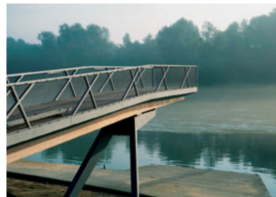
Aussichtssteg an der Mangfallmündung Mangfallbrücke und Steg auf den Innspitz
